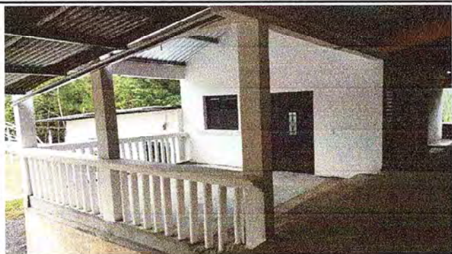
Foto 1: Vista de trabajos finalizados en el area de cocina (Colocacion de puertas, ventanas, barandales y habilitación de paredes).
