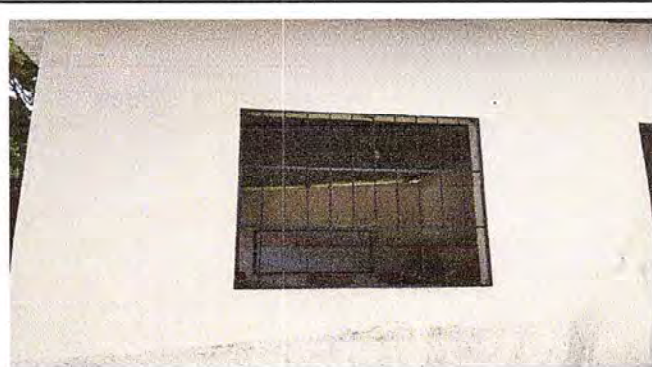
Foto 2: Renglon de trabajo (Balcones) ejecutados de manera adecuada a las necesidades que se tenian al inicio.
